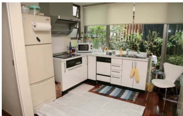
冷蔵庫は通常の使用状態のまま。その他の電化製品は待機電力だけを消費している状態。IH調理器の壁を隔てた背面に分電盤がある
